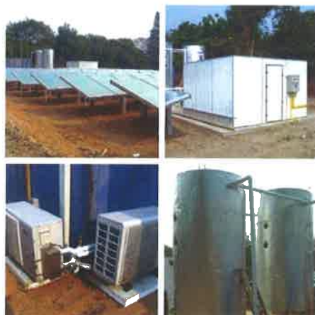
รูปที่ 18: ระบบผลิตน้ำร้อนพลังงานแสงอาทิตย์ ที่ห้างหุ้นส่วนจำกัด กูมิไพร์ (พพ., 2551)
