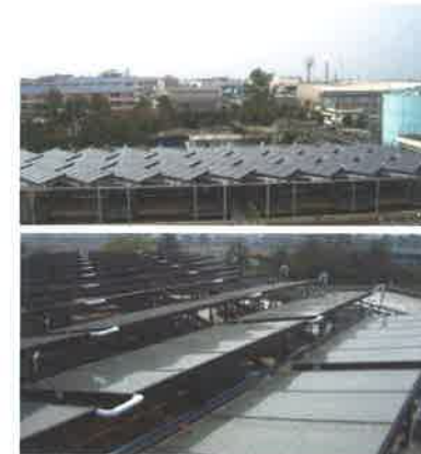
รูปที่ 15: ระบบผลิตน้ำร้อนพลังงานแสงอาทิตย์ ที่บริษัท ไทยรวมสินพัฒนาอุตสาหกรรม จำกัด (Sunmark, 2009)
