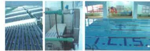
รูปที่ 22: รูปถ่ายและกลาง-แผงรับรังสีอาทิตย์ชนิดหลอดแก้วสุญญากาศรวมกับความร้อนเหลือทิ้งจากเครื่องปรับอากาศ (พพ., 2551), รูปชาว-สระว่ายน้ำในร่มที่โรงเรียนนานาชาติไทย-จีน (โปร โซลาร์ กรุ๊ป, 2551).
