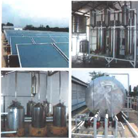
รูปที่ 16: ระบบผลิตน้ำร้อนพลังงานแสงอาทิตย์ ที่โรงสุรากลั่นชุมชนทิวไผ่ (กรมพัฒนาพลังงานทดแทนและอนุรักษ์พลังงาน [พพ.], 2551)
