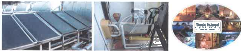
รูปที่ 20: ระบบน้ำร้อนพลังงานแสงอาทิตย์แบบผสมผสานที่โรงแรมดุสิต ไอส์แลนด์ รีสอร์ท ได้รับรางวัล Thailand Energy Award 2007 และ ASEAN Energy Award 2007 (พพ., 2550).
