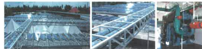
รูปที่ 24: ระบบปรับอากาศด้วยพลังงานความร้อนแสงอาทิตย์ที่ห้างเทสโก้ โลตัส จ.นครปฐม (Tesco Lotus, 2008)
